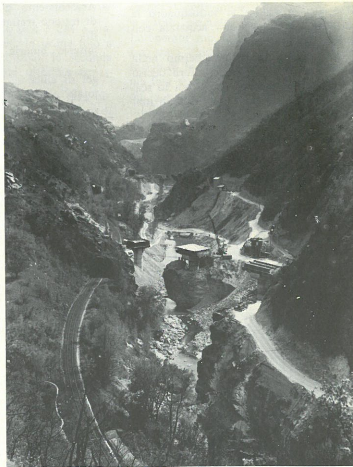
Fig. 15 - Vista panoramica dell'autostrada in costruzione.
