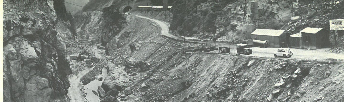
Fig. 1 - Visione parziale della gola nella zona del « Ponte delle Capre »: sulla destra si nota una delle centrali d'iniezione della Rodio, in basso il letto della Dora, in fase di magra, che scorre fra le fondazioni delle pile 2SC, 1SC, 2DC; in alto gli imbocchi dell'e gallerie « Petit Monde ».
