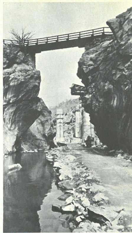
Fig. 3 - Vista del vecchio «Ponte delle Capre»; sullo sfondo pile già erette appartenenti al ponte omonimo. Notare i sottosquadri delle pareti rocciose prodotti dall'erosione del fiume.
